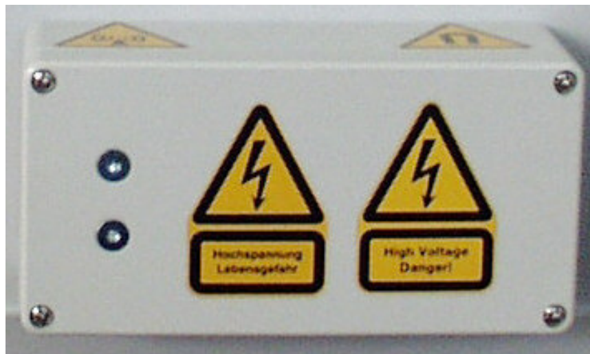
Abb. 3 : Hochstromanschlussgehäuse mit innen liegenden Anschlüssen
